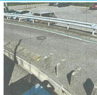
清溝を上げて受けを清掃中
