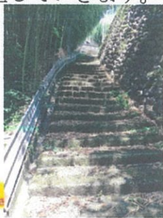
階段の整備と手すりの設置
