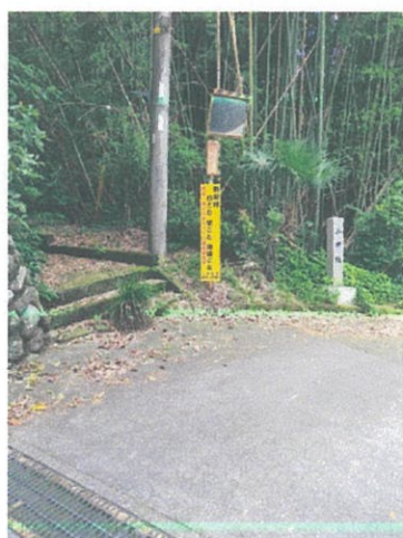
二井坂 看板裏側の木材破損 看板の取り換え完了（6月）
