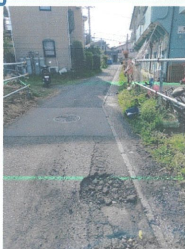
保育所あいかわ第二付近 緊急道路補修完了（4月）
