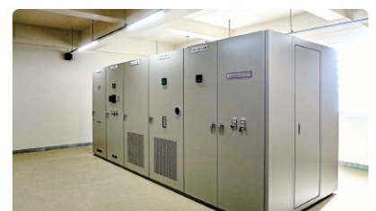
戸倉浄水場第2浄水池 浸水想定水位以上の高さに対応するための電気設備工事を実施
