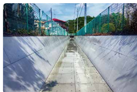
半縄地区雨水幹線水路
