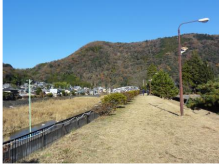
河川沿い堤防
