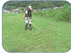
入り口階段下から 中津川右岸方向 へ雑草刈りです。
