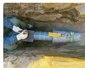
地盤変動に強い管へ更新中
