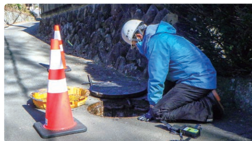
緊急点検の様子
