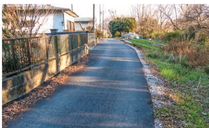
角田1709号線 舗装打換工事
