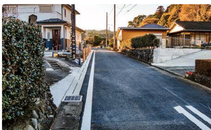
三増5321号線 側溝改修工事
