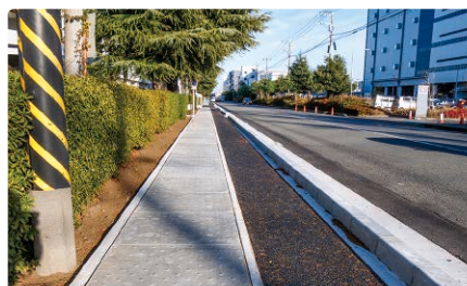
中津230号線 歩道整備工事
