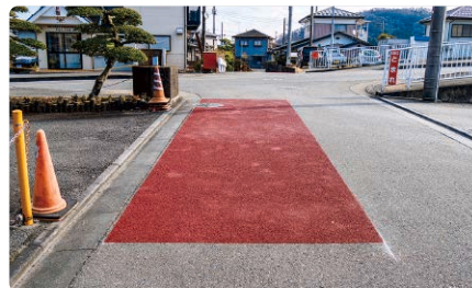
田代駐在所付近 カラー舗装工事
