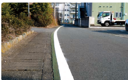
県央愛川農協高峰支所付近 区画線設置工事
