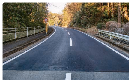
下平・館山118号線 舗装打換工事
