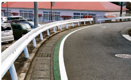
半原小学校付近 区画線設置工事
