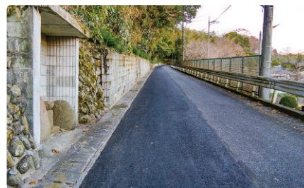
八菅山4142号線 舗装打換工事
