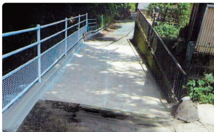
半原8137号線 災害予防工事
