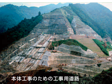
ダム本体のコンクリート打設は、RCD工法で施工。20トンダンプはインクラインで降下して打設面まで降り、打設現場まで運搬する。
