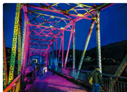
ライトアップが予定されている平山橋
