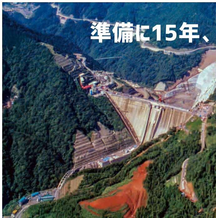
中津川の河床を工事用の道路として使用するなど、ダム建設は自然環境に細かな配慮をして進められました。
