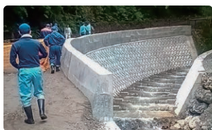
現地確認を行うパトロールの様子
