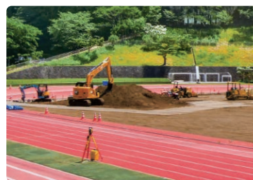
改修工事が進む 三増公園陸上競技場芝グラウンド
