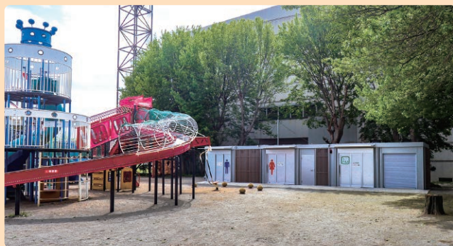
第1号公園トリム広場に新設した屋外トイレと防災倉庫
