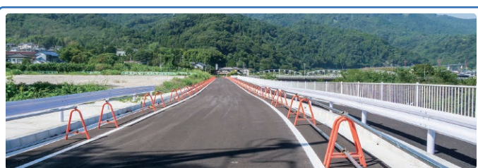
現在、整備を進めている「平山下平線第1工区改良工事」については、10月下旬に完了・開通予定です。
