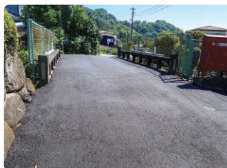
宮下橋(角田) 舗装打換工事
