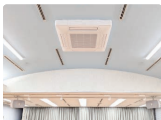
レディースプラザ エアコン更新工事
