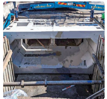
中津桜台地区の水路整備工事
