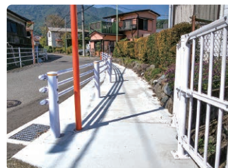
町道田代215号線 水路歩道形態構築工事
