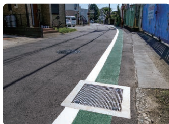
町道中津3507号線 排水改修工事
