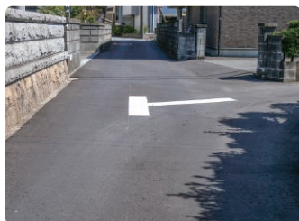
町道角田1226号線 舗装打換工事
