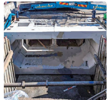
中津桜台地区の水路整備工事
