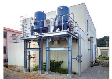
戸倉浄水場浸水対策工事(送水ポンプ) 浸水想定水位以上の高さに対応するために送水ポンプ盤を設置
