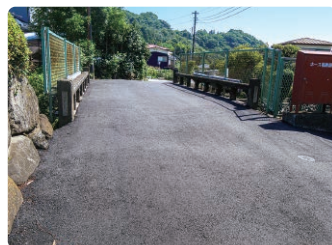
宮下橋(角田) 舗装打換工事
