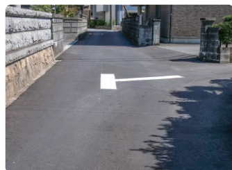
町道角田1226号線 舗装打換工事
