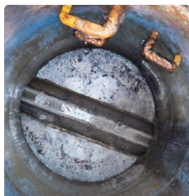
きれいに清掃したマンホール
