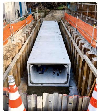
中津大塚下地区の水路整備工事
