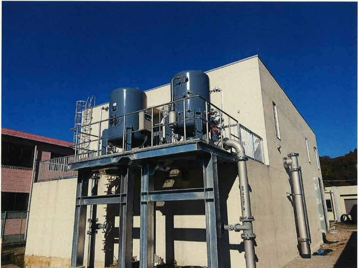
(戸倉浄水場第2浄水池)
