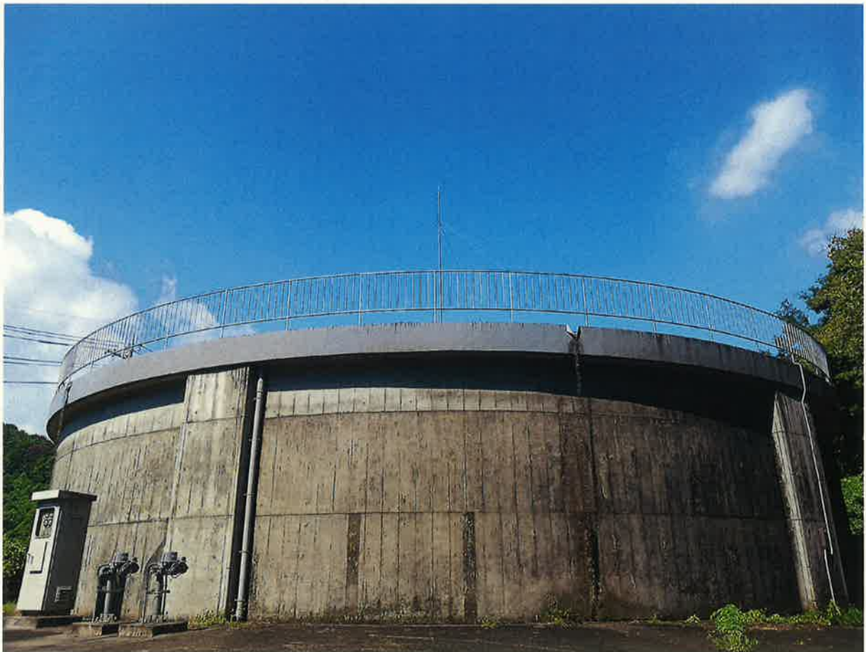
(志田第 1 配水池)
