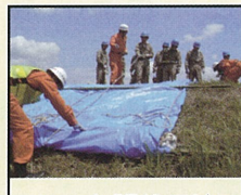
シート張り工法
