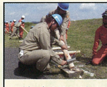
杭づくり工法
