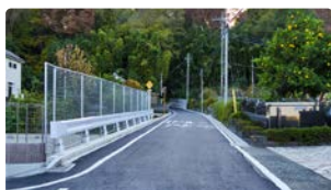
拡幅工事を実施した道路
