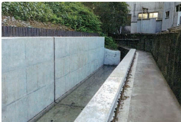
中津大塚下地区の水路整備工事
