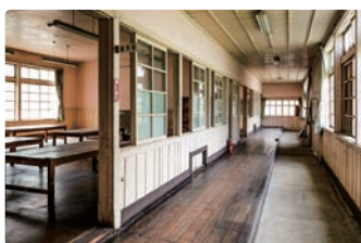
緊急避難に備えた廊下脇の土間
