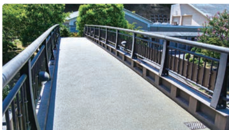
愛川聖苑の第1駐車場と建物の間に架かる歩道橋の舗装工事を実施しました。
