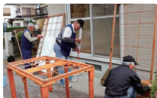
障子の張替え作業
