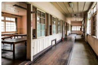
緊急避難に備えた廊下脇の土間
