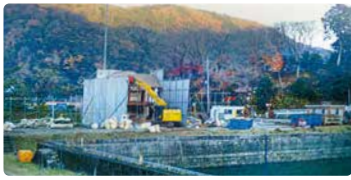
既存建物の撤去
