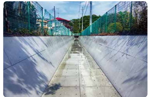
半縄地区雨水幹線水路
