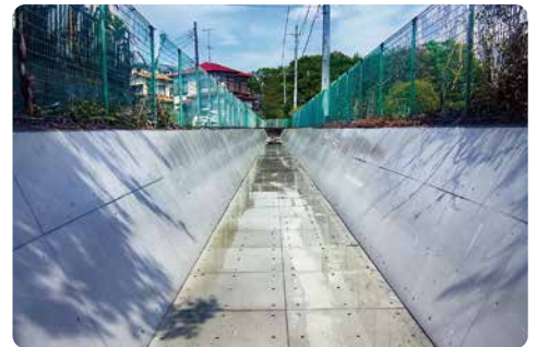
半縄地区雨水幹線水路
