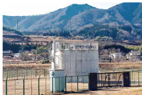
浸水対策工事でかさ上げした 戸倉浄水場 第4水源
