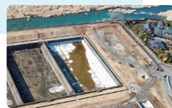
現在(建物の撤去完了)
