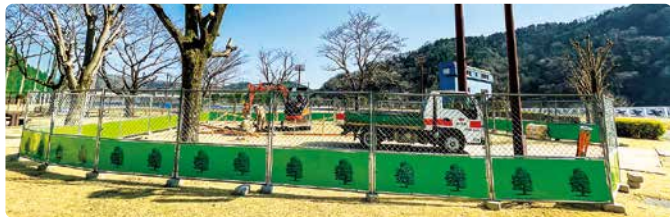
設置に向けて工事が進む広場
