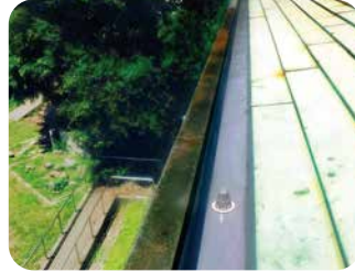
修繕工事が完了した 高峰小学校体育館の雨どい
