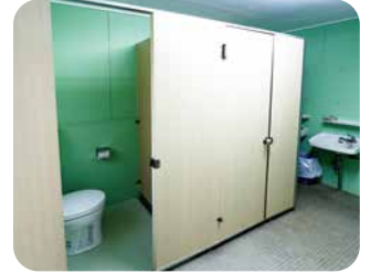
洋式化工事が完了した 中津第二小学校体育館のトイレ
