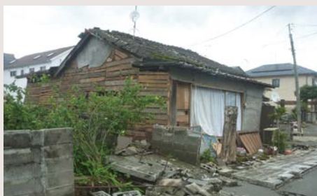
平成28年熊本地震で倒壊した建物とブロック塀
