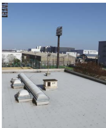
第1号公園体育館屋上
