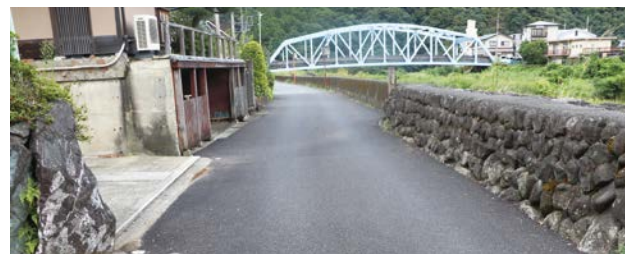
町道半原 7510 号線（川北児童館付近）
