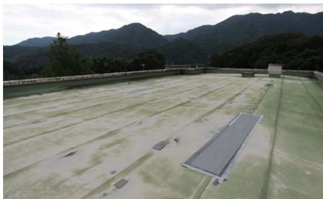
愛川中学校の特別教室棟の屋上
