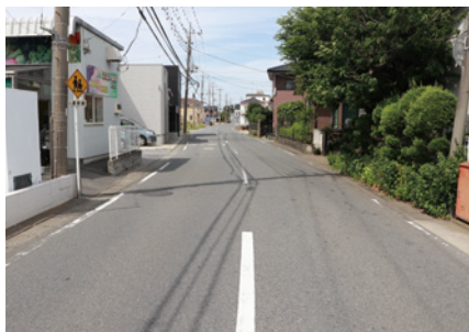
補修を行う中津・大塚地区の道路
