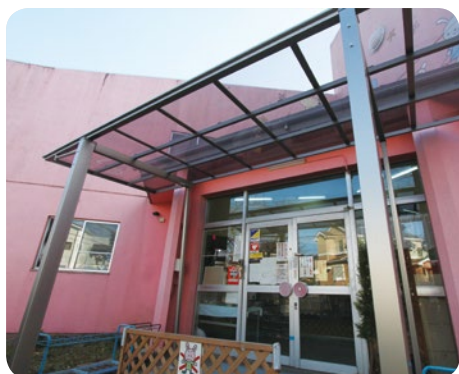
設置した雨どいとテラス屋根
