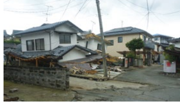
熊本地震の被害の様子
