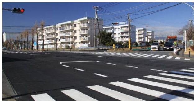
舗装が新しくなった桜台団地入口交差点
