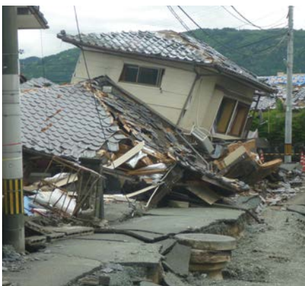
熊本地震の被害の様子
