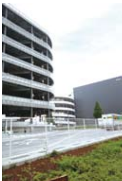
内陸工業団地内、大型物流施設
