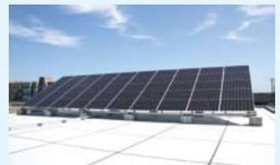
屋上に太陽光パネルを設置しています。発電された電気は、健康プラザの電源として使われます。発電能力は 10 キロワットで各部屋の照明や事務機器の一部などに対応できます。
