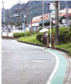
通学路カラー舗装工事
