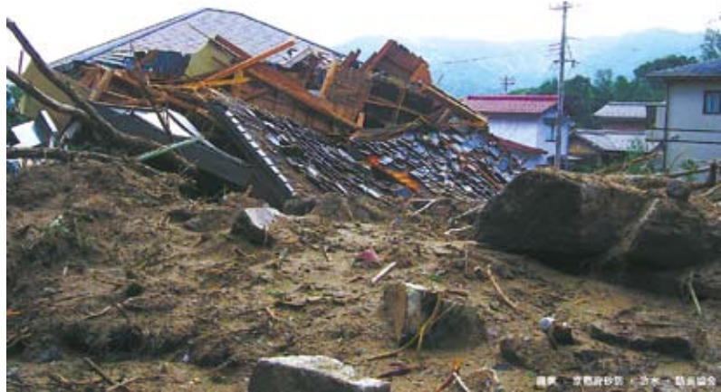
土石流によって全壊した家屋
