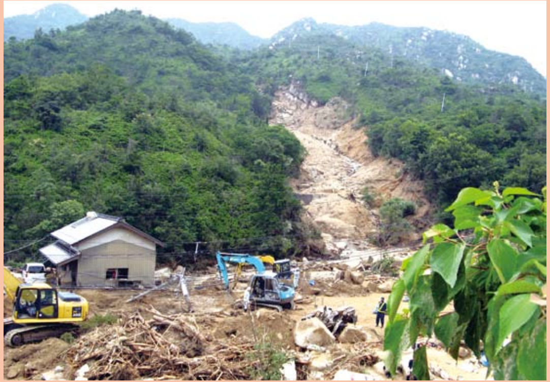
土石流が通った跡
