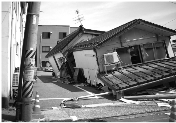
新潟県中越地震による被害（写真提供：神奈川県）
