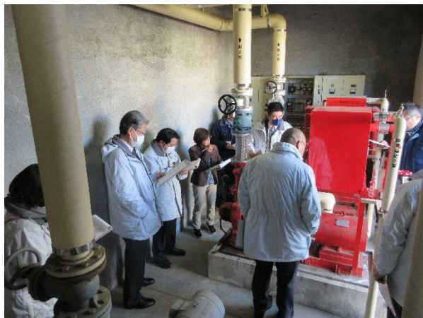
1/16 現地調査 (中原中学校) 学校施設整備事業費：中学校消防設備改修工事
