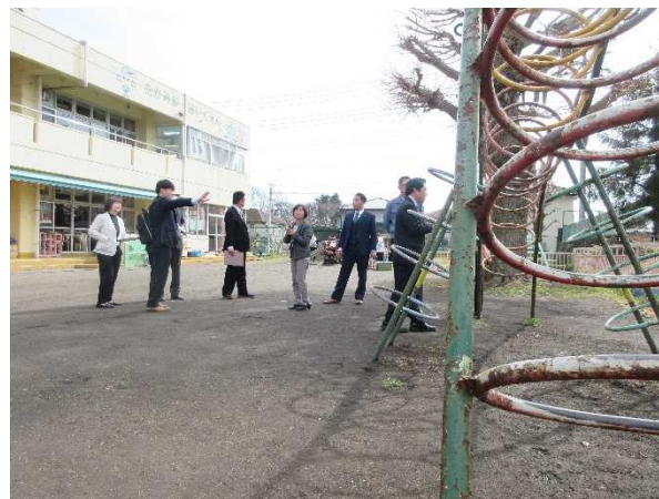
3/13 現地調査 (高峰保育園) 保育所施設維持管理経費：高峰保育園遊具塗装工事
