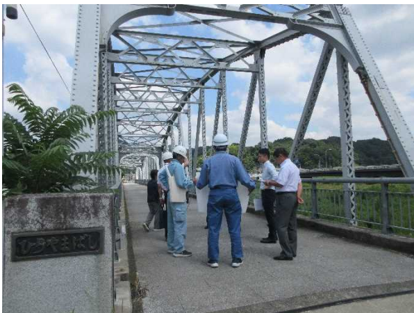
7/31 現地調査(平山橋)
