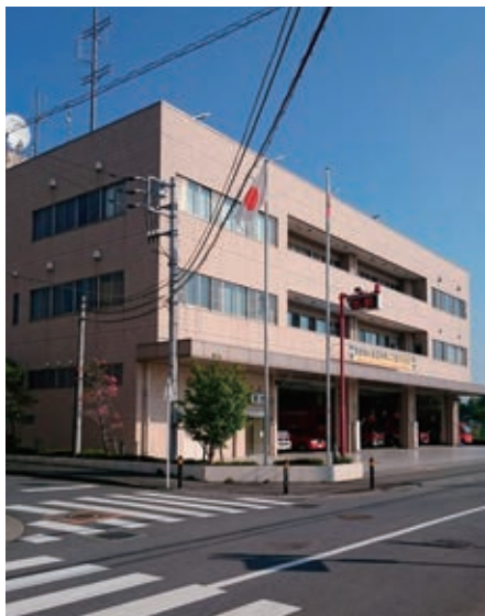
危機管理室が設置され、防災対策の中枢を担う消防庁舎
