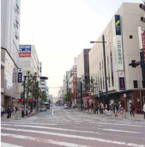
無電柱化された本厚木駅前
