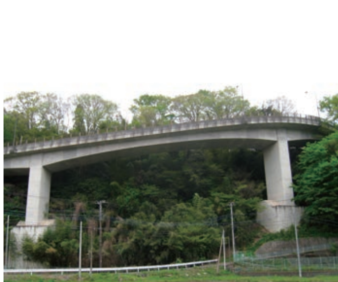
本年度補修予定の中津大橋
