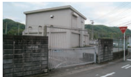
整備予定の中津浄水場
