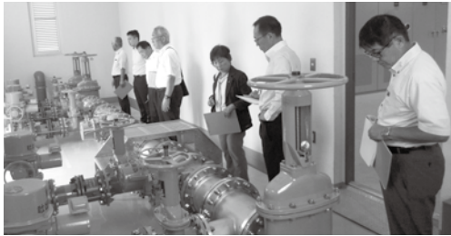
送水ポンプの調査（戸倉浄水場）
