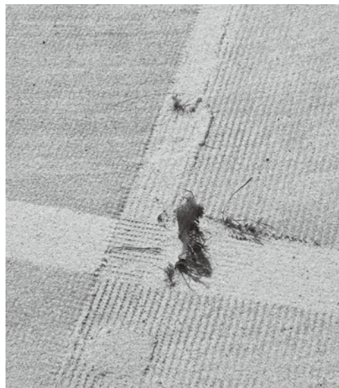
人工芝のテニスコートの一部がはがれている状態
