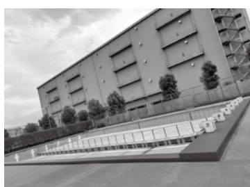
第1号公園プール
