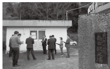
志田第一配水池 電動弁設置工事の調査
